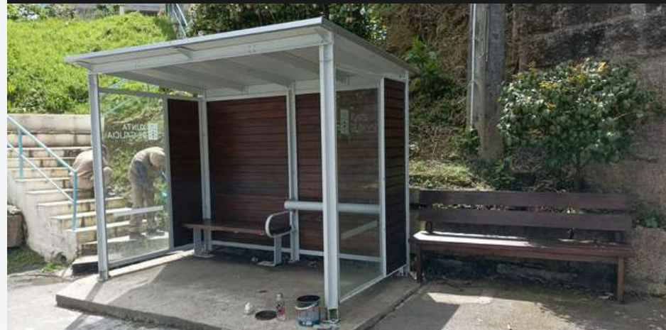
Instalación marquesiña en Tameiga.
